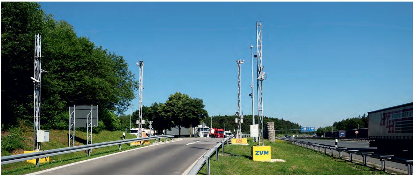
Sensorik im Ausfahrtsbereich Testfeld Gelbsee
